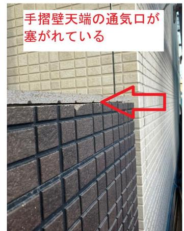
そのような通気経路を遮断された施工をされると、夏場などは膨張した空気でサイディング材の変形などのトラブルを発生させます。
